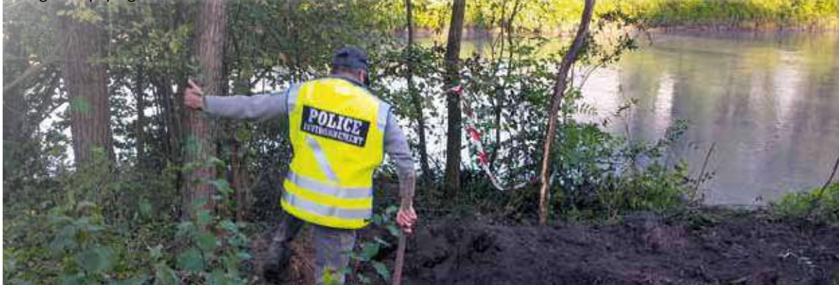
Opération de démantèlement d'un terrier de castor sous contrôle de l'Office National de la Chasse et de la Faune Sauvage dans le cadre du projet d'aménagement hydraulique « Isère amont » du SYMBHI afin que cette espèce protégée ne soit pas détruite lors des travaux.
