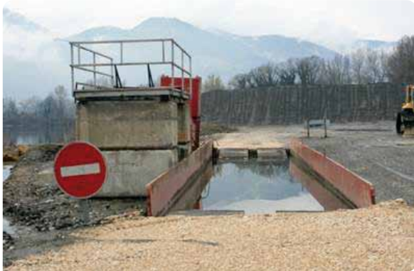
Dispositif de nettoyage d'engin en sortie de site contaminé par des plantes exotiques envahissantes. Projet d'aménagement hydraulique « Isère amont » du SYMBHI.
