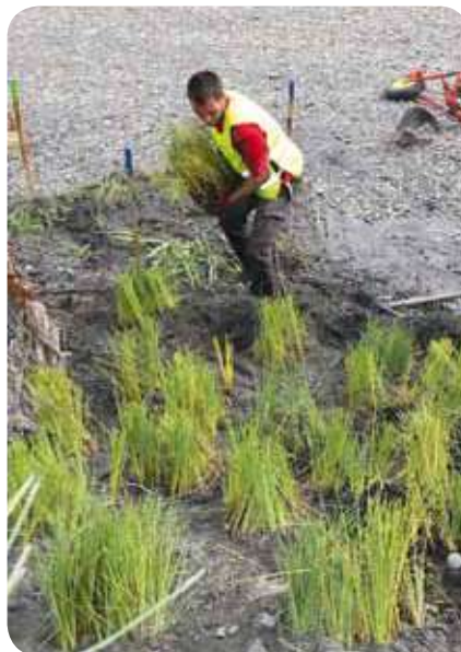
Travaux de plantation de petite massette, plante protégée, demandant une bonne connaissance écologique de l'espèce. Projet d'aménagement hydraulique « Isère amont » du SYMBHL.
