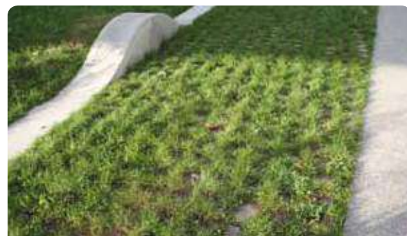
Pavage non jointoyé d'une allée piétonne. Parc Ouagadougou, Grenoble 160 000 hab.
